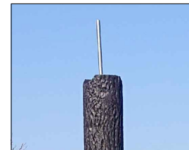
【写真3】ボルト取付
