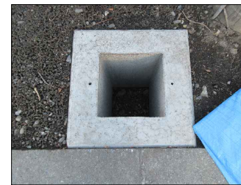
【写真1】基礎部例（ポイド・コンクリートブロック）
