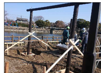
【写真4】支柱 リン木固定
