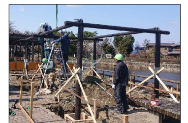
【写真5】縦梁設置
