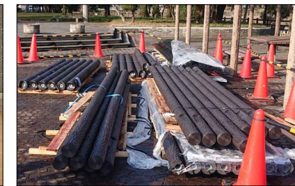
【写真2】搬入部材例（金具類・擬木類）
