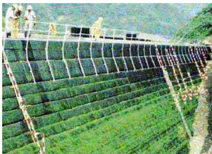
アデムを使用した補強土壁
