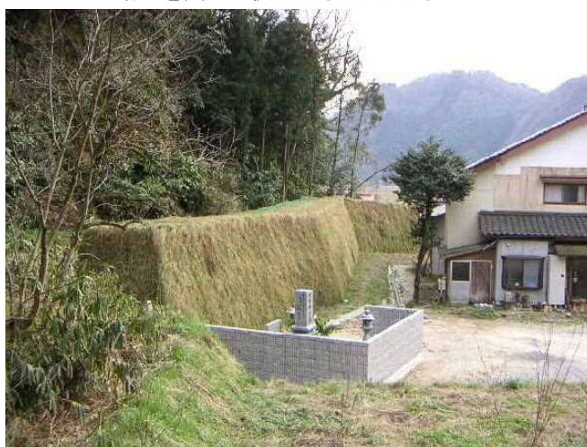
植生により周辺環境と調和したジオロックウォール
