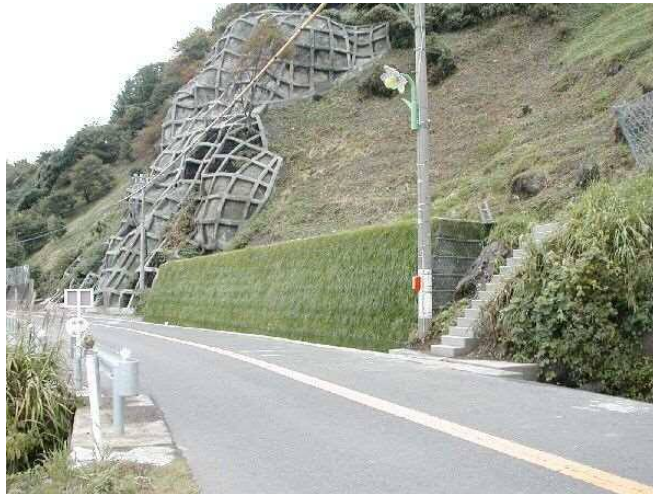
道路脇に設置した場合の施工写真
