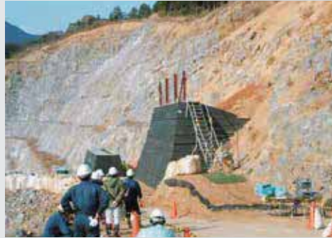
実物落石・土砂崩れ衝撃実験
