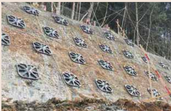
切土法面補強
