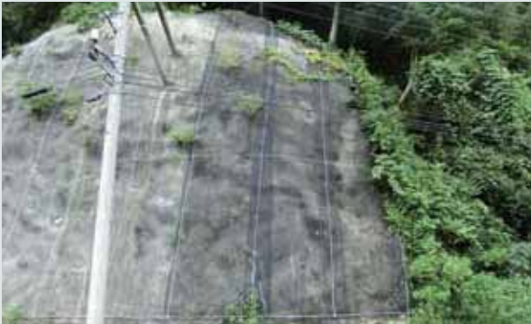
福井県(覆式落石防護網工)
