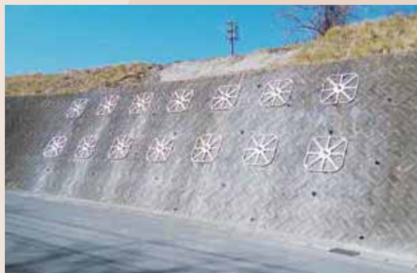
老朽化擁壁補強
