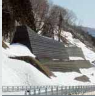
雪崩防護擁壁工 ジオスノーウォール
