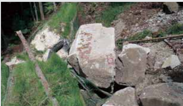
宮城県大崎市鳴子／Ⅰ型／推定落石エネルギー：約2500kJ／事故後の対応：全撤去後再構築を行いました
