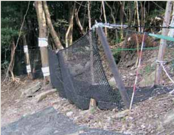
福岡県伊良原ダム
