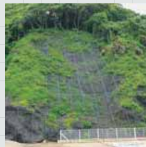
覆式落石防護柵工 GMネット
