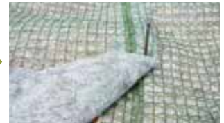
隣接する製品を所定の位置でラップ アンカーおよび止め釘で固定
