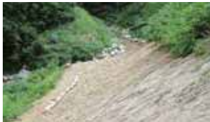
法面を平滑に整形 浮石、雑草等の除去
