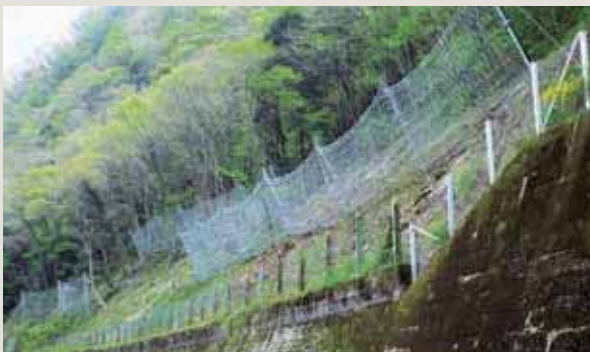
MJ2000 (岡山県高梁市備中町布賀)
