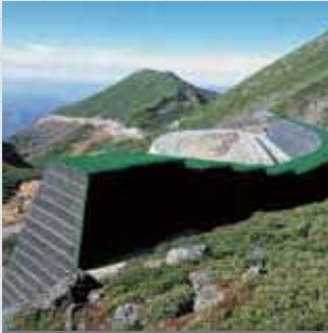
落石防護土堤工 ジオロックウォール
