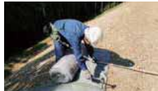
法肩部分の固定
