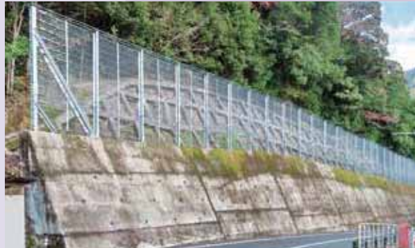
奈良県 (かさ上げタイプ/ 柵高不足に対する対策工)
