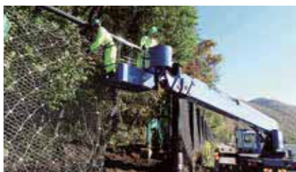
パネル式ワイヤネット・金網の取り外し状況
