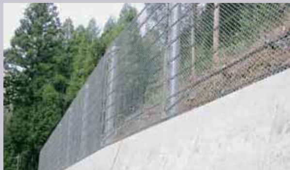
滋賀県彦根市(路側擁壁タイプ)
