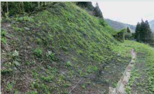
石川県(覆式落石防護網工)
