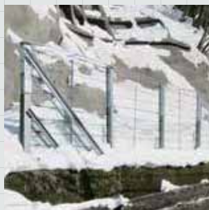
落石防護柵工 ストロンガー工法
