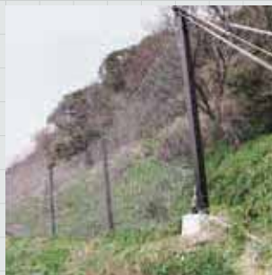
落石防護柵工 マクロフェンス
