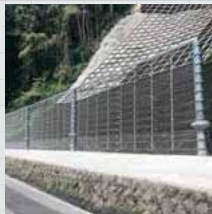
落石防護柵工 ループフェンス
