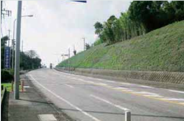
宮崎県(切土斜面 法面保護)
