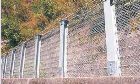
富山県 (補強タイプ/ 可能吸収エネルギーの向上)
