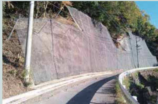
山梨県(既存柵(ポケット式落石防護網工)補強)
