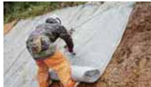
法肩より敷設 アンカーおよび止め釘で固定
