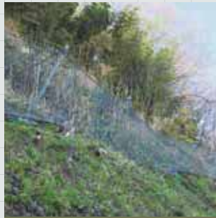
落石防護柵工 SPARCフェンス
