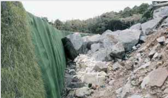
東京都新島／Ⅲ型／推定落石エネルギー：約7000kJ／事故後の対応：防護マット破損部を取り換えました
