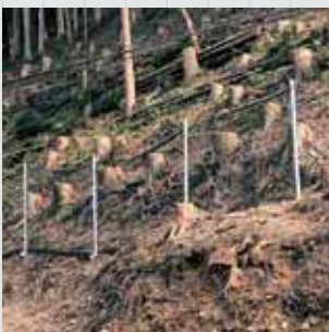
落石防護柵工 GMネット防護柵
