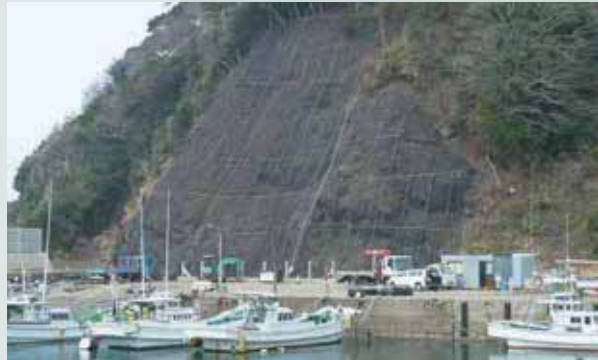
長崎県(覆式落石防護網工)
