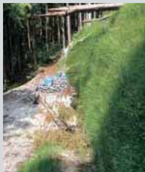
宮城県大崎市鳴子／Ⅰ型／推定落石エネルギー：約2500kJ／事故後の対応：全撤去後再構築を行いました
