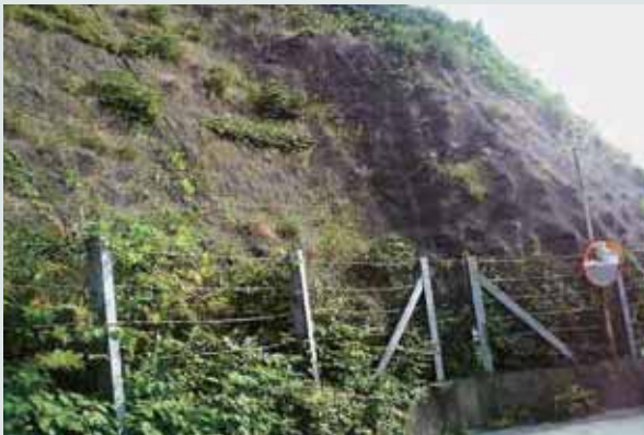
滋賀県米原市(自然斜面 法面保護)
