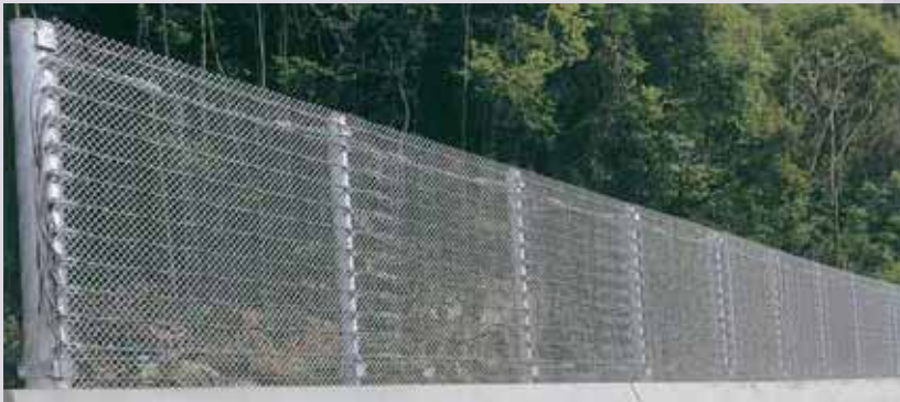
愛媛県南宇和郡愛南町(路側擁壁タイプ)
