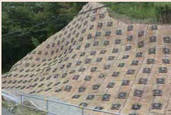
切土法面補強
