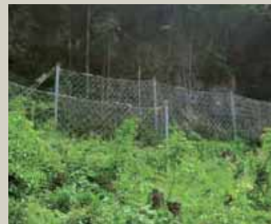
群馬県吾妻郡嬬恋村 ・5000kJ タイプ、柵高:6.0m、施工延長:30m
