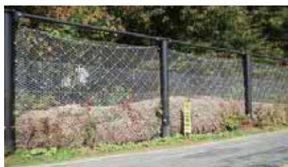
土砂捕捉状況
