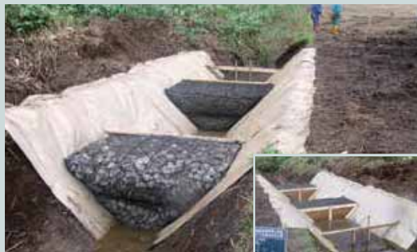
かごマット(汚濁防止対策)
