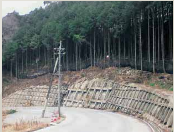
福岡県伊良原ダム
