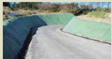
風力発電取付道路
