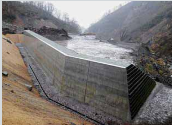
長野県下水内郡栄村(壁高7.0m)
