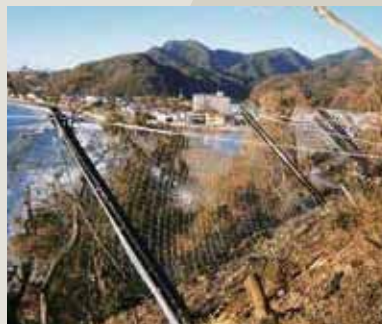
静岡県賀茂郡西伊豆町 ・2000kJ タイプ、柵高:5.0m、施工延長:50m
