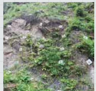
地山補強土工 マクロネットHR
