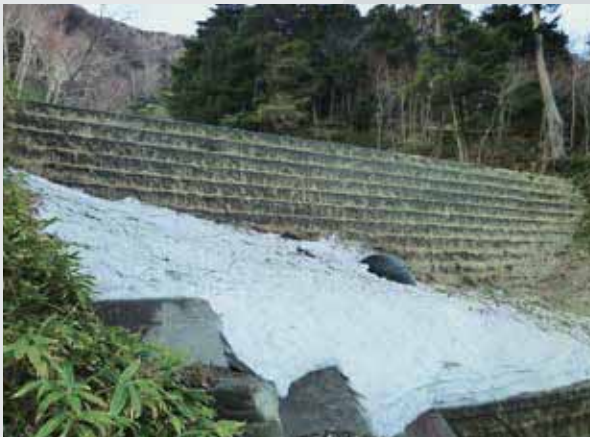
栃木県日光市(壁高9.5m)
