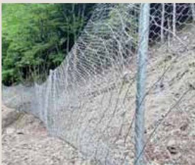
栃木県日光市足尾町 ・750kJ タイプ、柵高:3.5m、施工延長:50m
