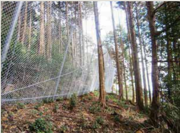
静岡県熱海市 柵高:3.0m, 施工延長:320.0m
