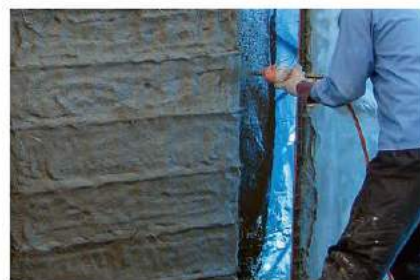
吹付け作業 タイプⅡ
