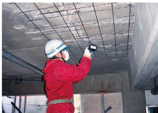
スラブ下面への補強筋配置
