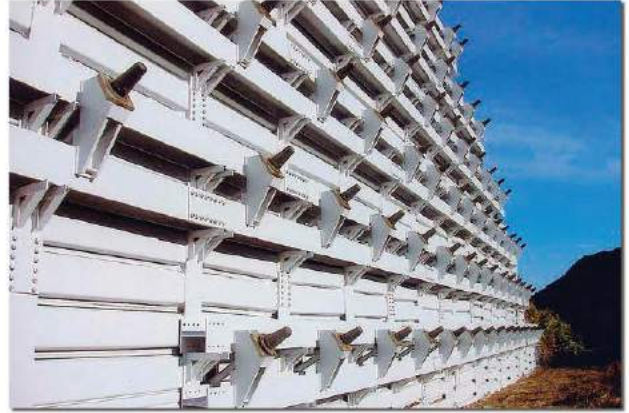
【のり面補強鋼材の防錆】
