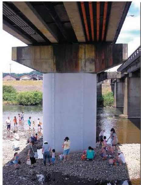
【鋼板巻立ての防錆塗装】
