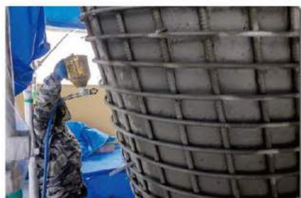
吹付け作業 タイプⅠ
