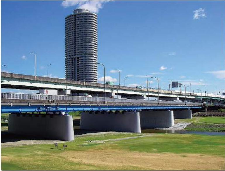
【河積阻害率の制約下での施工例】
