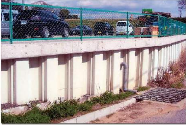
【鋼矢板の防錆】
