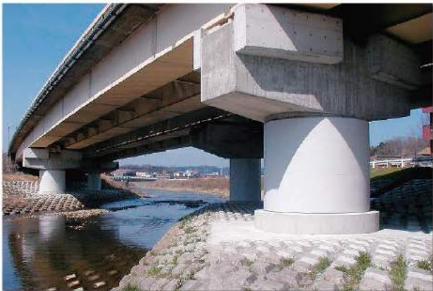
【鋼板巻立ての防錆塗装】
