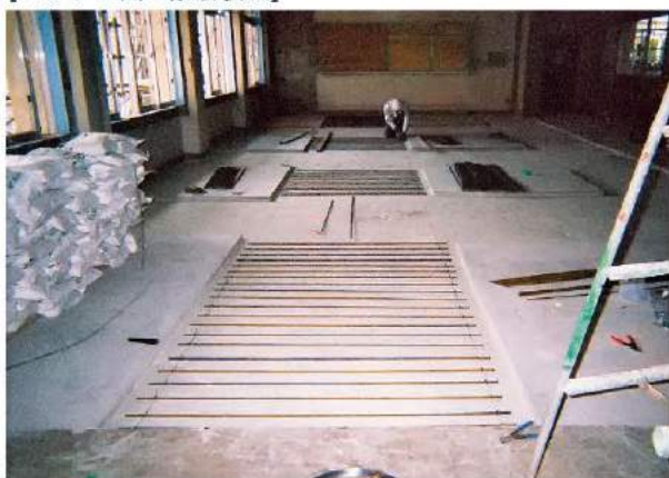
【スラブ上面の配筋状況】
