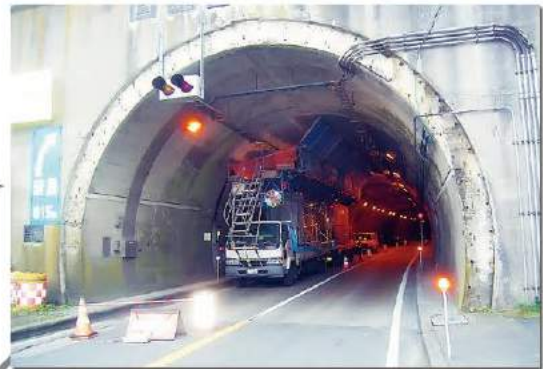
施工中(足場状況)
