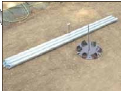
2 ガイドプレートの仮固定
