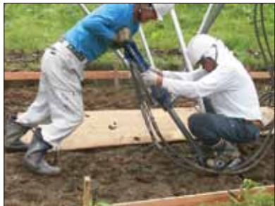
3 鋼管杭の打ち込み
