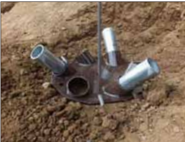
4 鋼管杭の打ち込み完了
