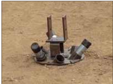
6 C-LESS基礎 設置完了
