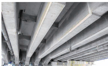
RC主桁の補強
