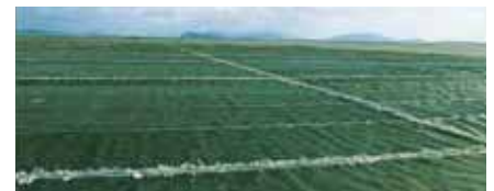
軟弱地盤の表層処理
