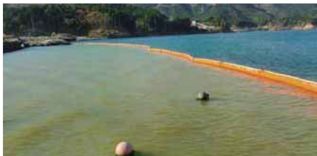
漁港での災害復旧の際に汚水の流出を防いだ事例
