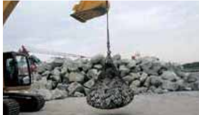
5 吊り上げ移動
