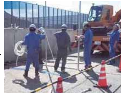
3 ガイドレールの設置
