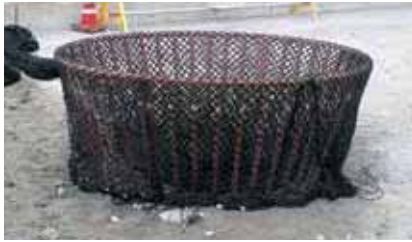
1 袋材設置(袋の底を地面につけて設置)
