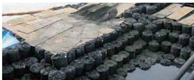
土留工 施工ヤードの土留として用いた事例
