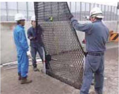
4 ネットバッファ設置
