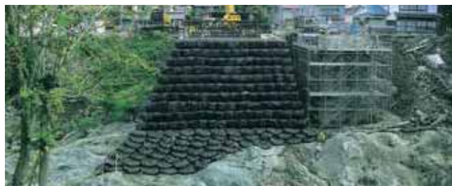
仮設工 仮設橋台にBUウォール工法と併用して用いた事例
