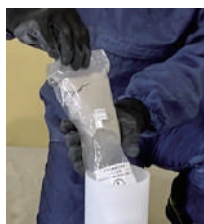
粉体①を全量投入する。 (遅延剤使用時は、粉体①投入後に、遅延剤投入)
