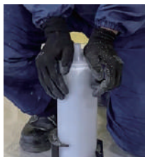
カートリッジに注入口を取付ける。
