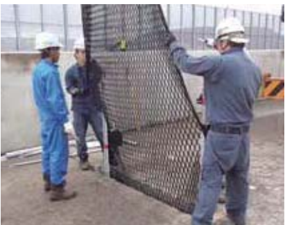
4 ネットパッド設置
