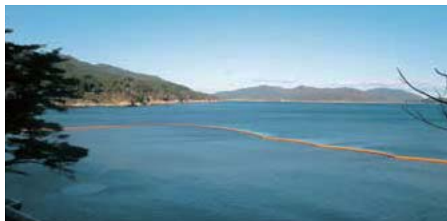
砂浜の再生工事の際に汚水の流出を防いだ事例
