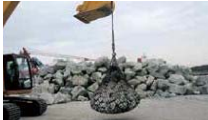
5 吊り上げ移動
