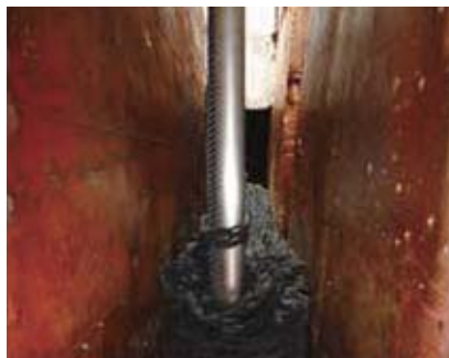
5 ネットパッド設置状況
