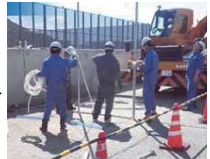
3 ガイドレールの設置
