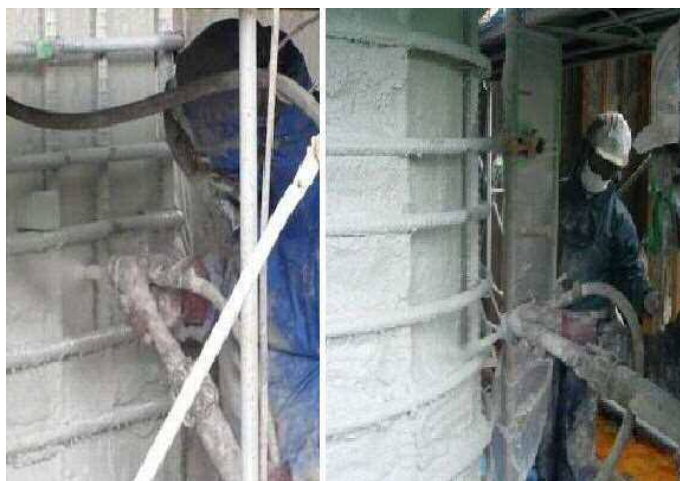
増厚作業状況(吹付施工)
