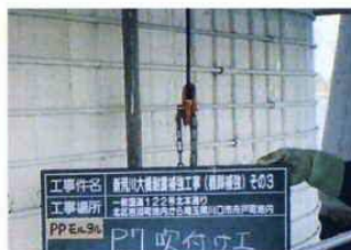
施工中 2 (機械継手使用)
