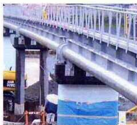
補強前(奥)と補強後(手前)
