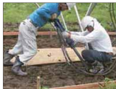
3 鋼管杭の打ち込み
