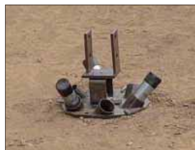
6 C-LESS基礎 設置完了
