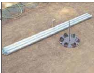
2 ガイドプレートの仮固定
