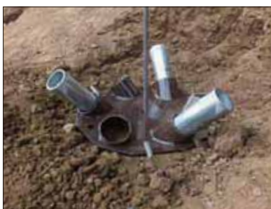
4 鋼管杭の打ち込み完了
