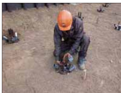
5 連結金具の取付け
