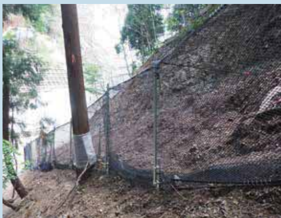
簡易落石防護柵工
