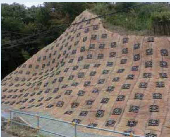
切土のり面補強
