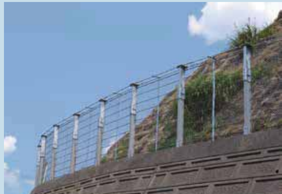
福井県(かさ上げタイプ/柵高不足に対する対策工)
