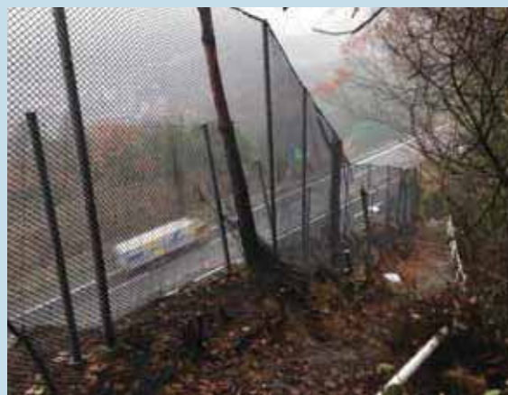
広島県(獣害対策兼小規模落石対策工)
