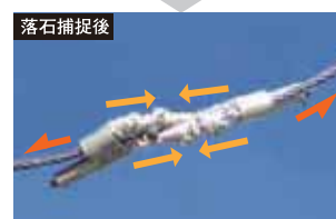
ワイヤロープに張力が発生し、アルミ鋼管が変形
