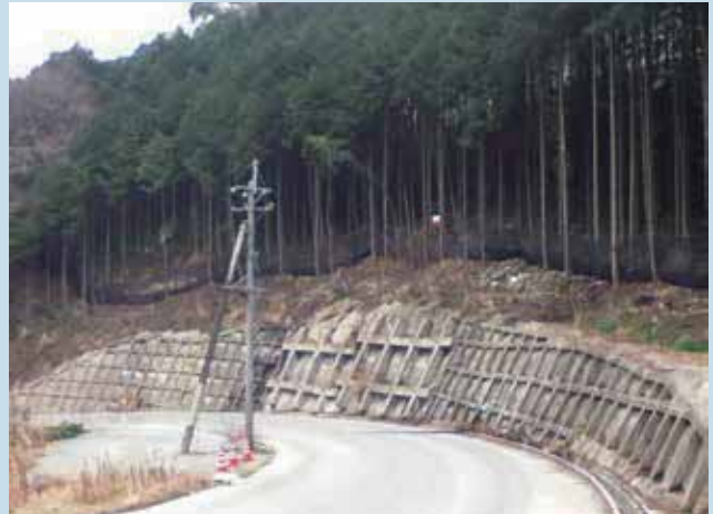
福岡県伊良原ダム
