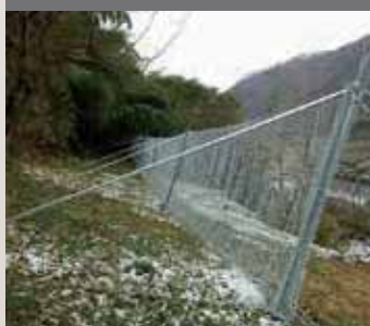
落石防護柵工 ARC フェンス
