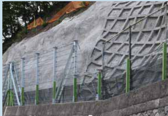
山梨県(部分かさ上げタイプ/必要な箇所のみかさ上げ)
