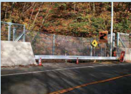
群馬県利根郡みなかみ町（路側地山根入れタイプ）
