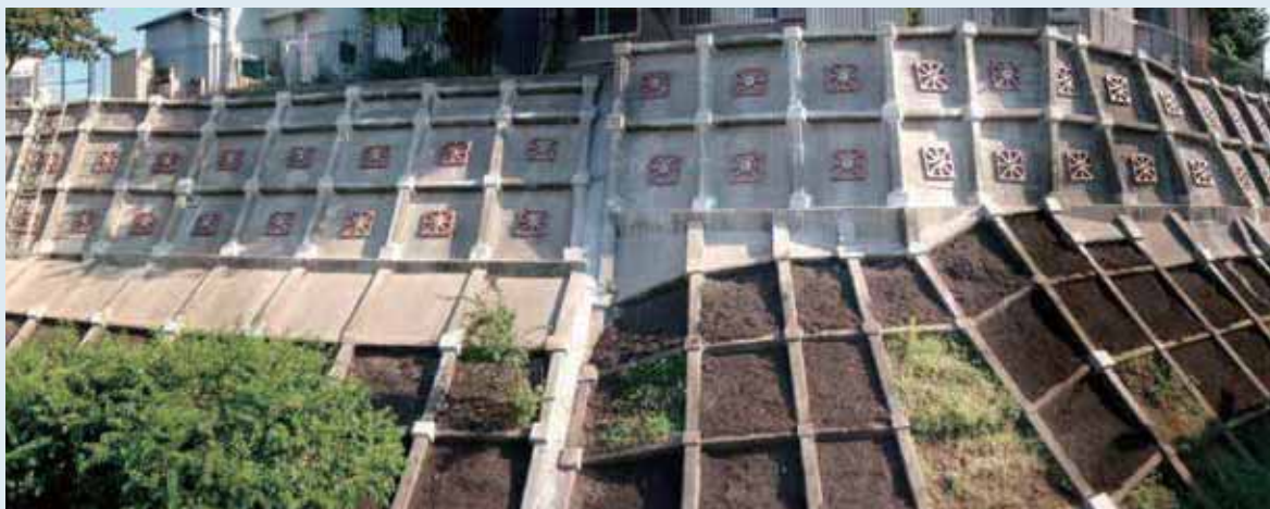
老朽化擁壁補強
