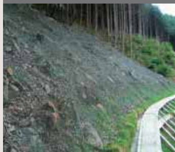
覆式落石防護網工・繊維ネット張工 ECO 落石ネット
