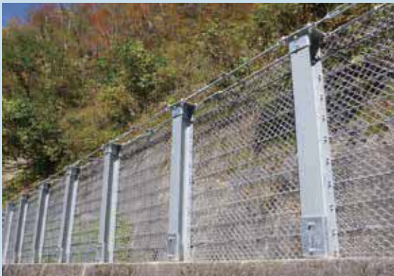
富山県(補強タイプ/可能吸収エネルギーの向上)
