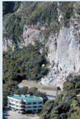
東京都新島/Ⅲ型/推定落石エネルギー:約7000kJ/事故後の対応:防護マット破損部を取り換えました
