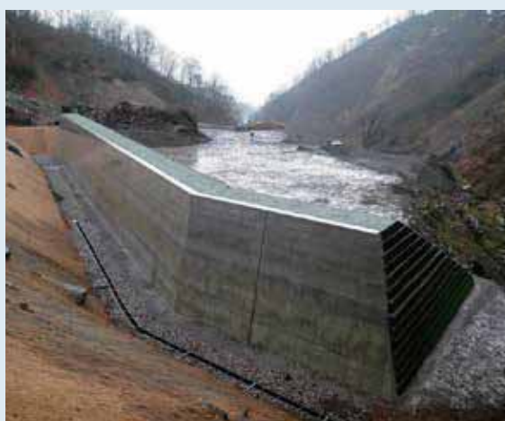
長野県下水内郡栄村（壁高7.0m）
