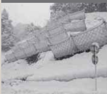
雪崩予防柵工 ARC フェンス S タイプ
