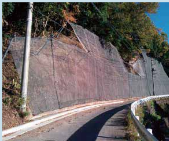
山梨県（既存柵）のり面保護
