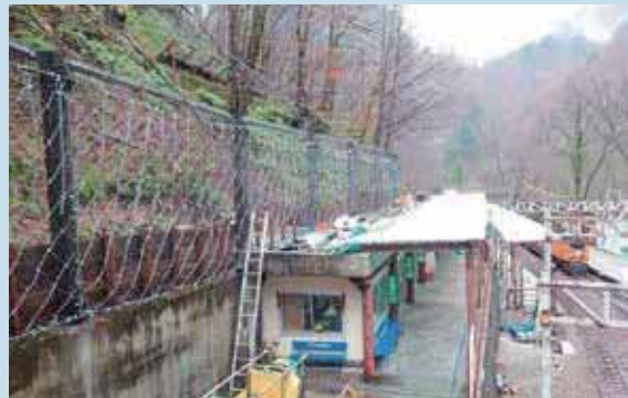
富山県黒部市宇奈月町（黒部峡谷トロッコ電車 鐘釣駅） 柵高：3.0m（着色タイプ）
