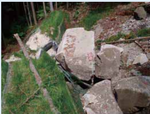
宮城県大崎市鳴子/I型/推定落石エネルギー:約2500kJ/事故後の対応:全撤去後再構築をおこないました
