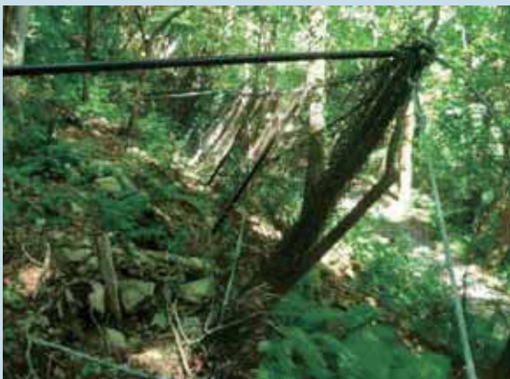
長野県安曇野市 柵高：2.0m, 施工延長：55.0m
