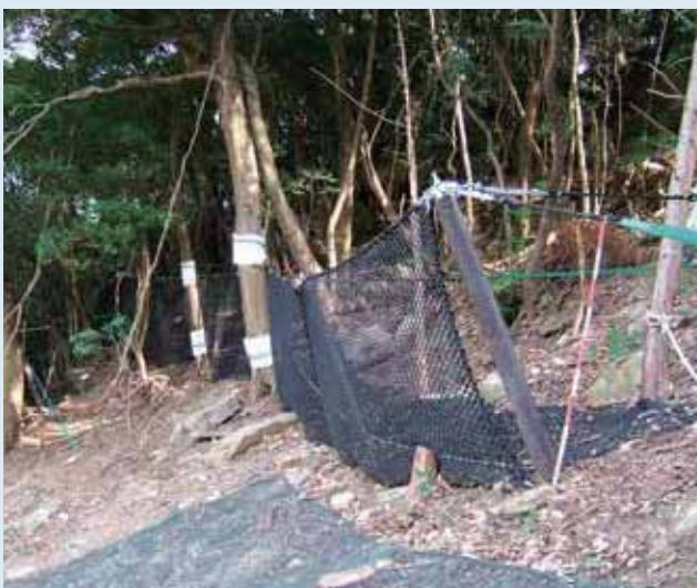
福岡県伊良原ダム
