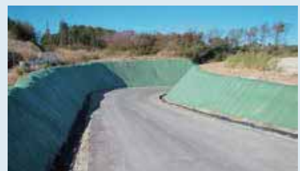
風力発電取付道路
