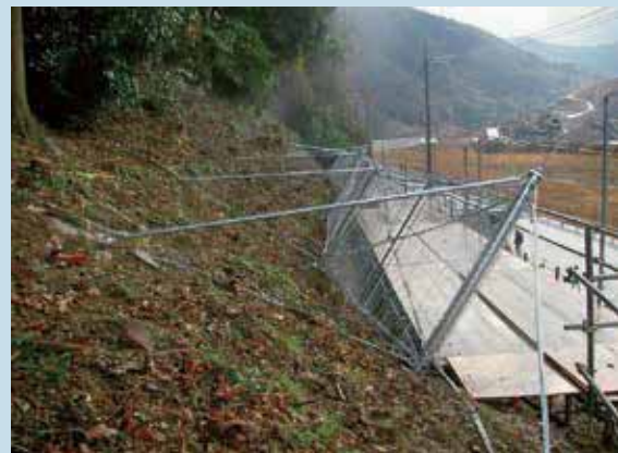
島根県浜田市 柵高：2.0m, 施工延長：25m
