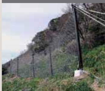
落石防護柵工 マクロフェンス
