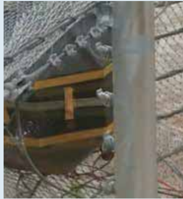
変位制限装置が解除され広範囲にてエネルギーを吸収します
