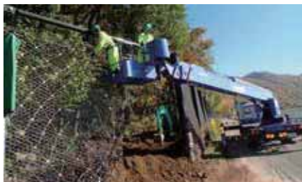
パネル式ワイヤネット・金網の取り外し状況
