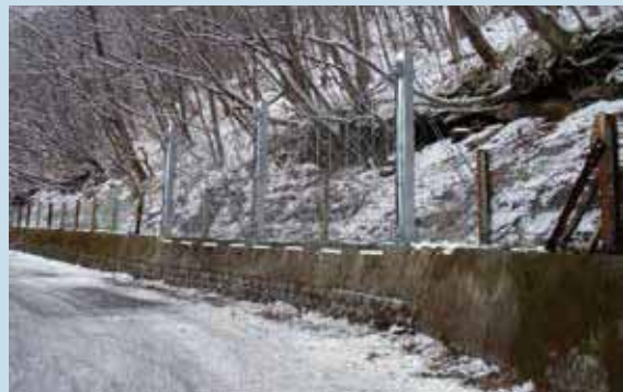
群馬県高崎市箕郷町 【補強前】柵高：2.0m 【補強後】柵高：3.0m、対応落石エネルギー：100kJ
