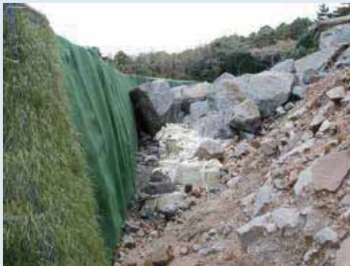
東京都新島/Ⅲ型/推定落石エネルギー:約7000kJ/事故後の対応:防護マット破損部を取り換えました
