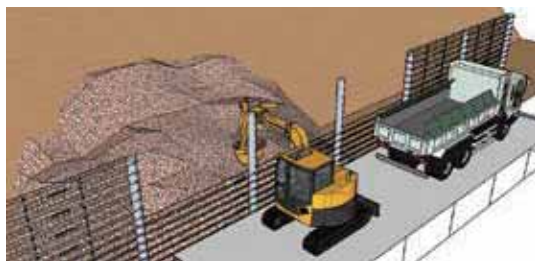
谷側での除去作業例
