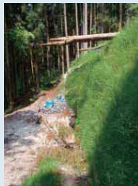
宮城県大崎市鳴子/I型/推定落石エネルギー:約2500kJ/事故後の対応:全撤去後再構築をおこないました
