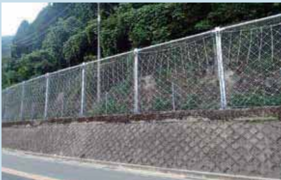
兵庫県美方郡新温泉町 【補強前】柵高：2.0m、対応落石エネルギー：50kJ 【補強後】柵高：4.0m、対応落石エネルギー：200kJ
