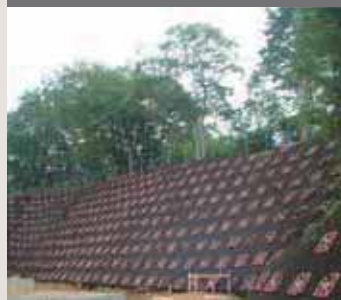
地山補強土工 MK 受圧板
