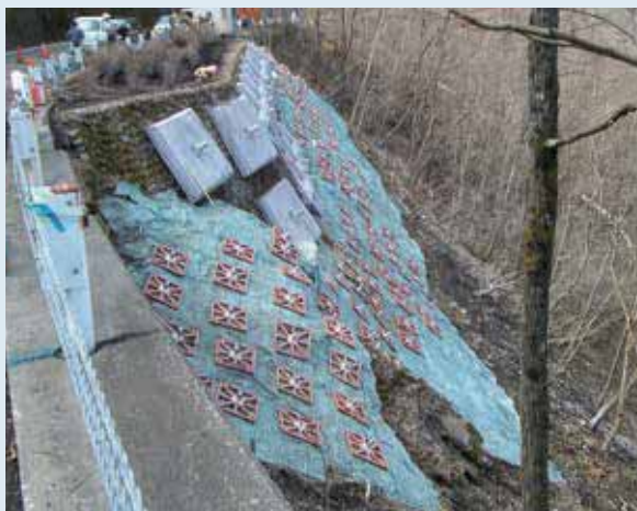
自然斜面補強
