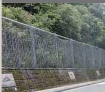
既設落石防護柵補強工 再強フェンス
