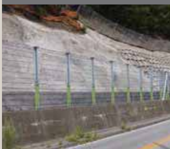
既設落石防護柵補強工 ストロンガー工法
