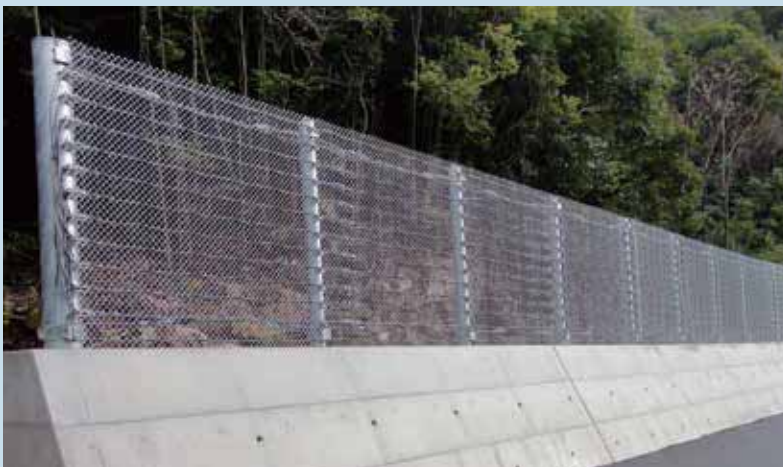
愛媛県南宇和郡愛南町（路側擁壁タイプ）
