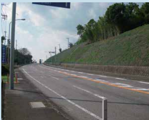
宮崎県（切土斜面）のり面保護
