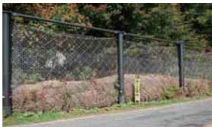
土砂捕捉状況
