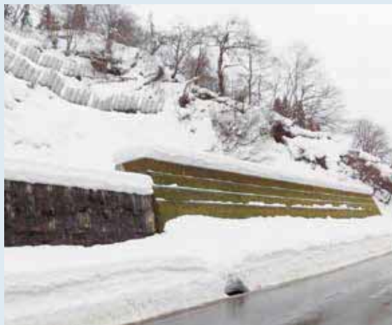
山形県最上郡真室川町（壁高4.5m）
