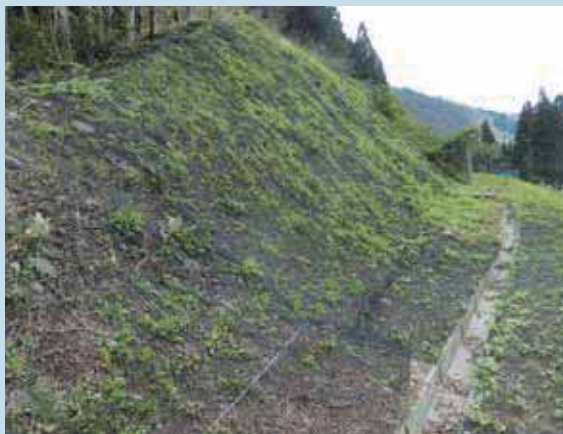
石川県(覆式落石防護網工)
