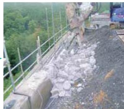
写真-2 笠石コンクリート取り壊し
