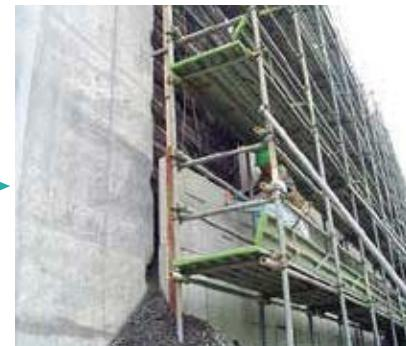
写真-6 壁面材の取り付け
