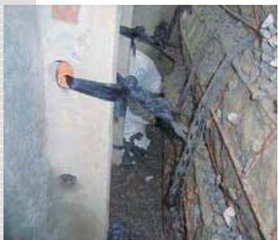
写真-7 壁面材とグリッドベルトの連結
