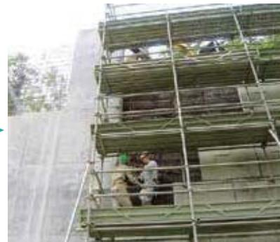
写真-5 壁面材の撤去完了
