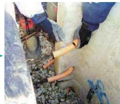
写真-3 グリッドベルトの切断
