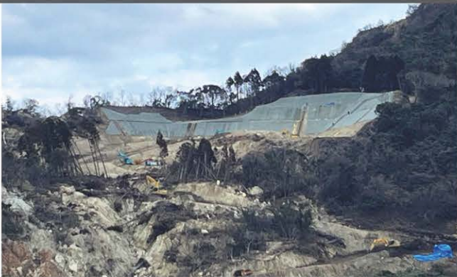
地すべり対策工事 石川県珠洲市 GS-RNSK
