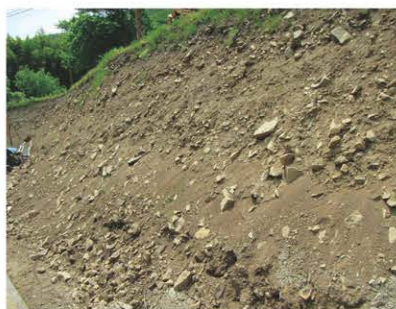
〔施工前〕 6 分勾配
