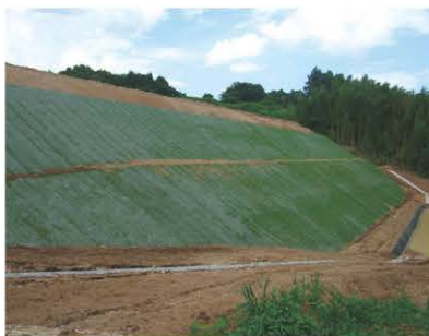
〔施工後〕 1 か月 九州北部豪雨直後
