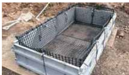
1 型枠に網地を設置
