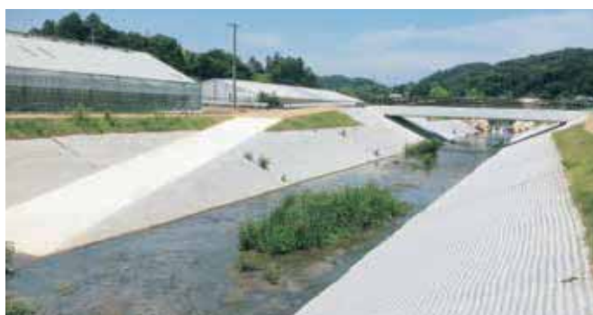
のり面保護工 河川ののり面保護として用いた事例
