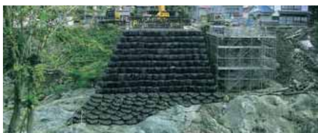
仮設工 仮設橋台にBUウォール工法と併用して用いた事例
