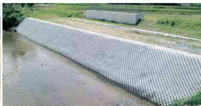
のり面保護工 河川ののり面保護として用いた事例
