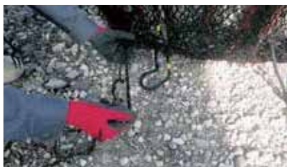
2 網地を型枠に拘束
