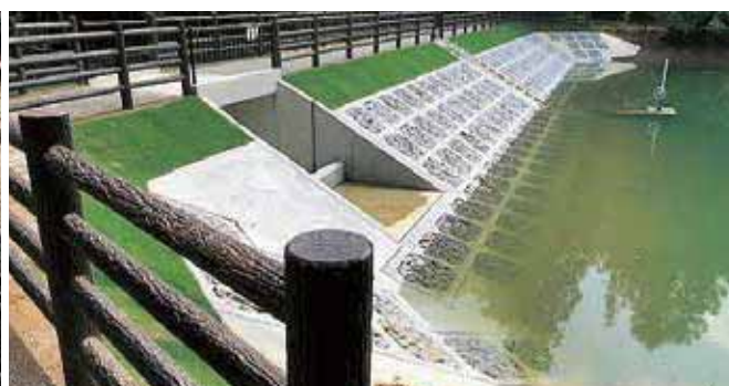
護岸工 ため池堤体改修工事にて遮水性ゾーンに敷設した事例
