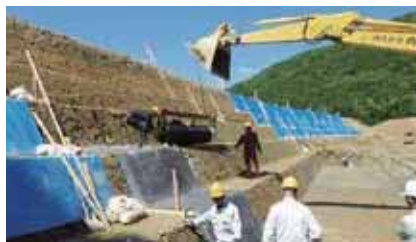
1 シートの敷設
