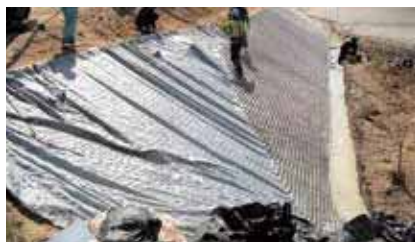
2 モルタル注入
