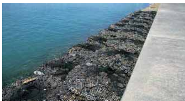
マウンド被覆 防波堤のマウンドの被覆材として用いた事例
