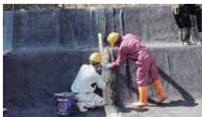
4 重ね合わせ部処理(法面部)
