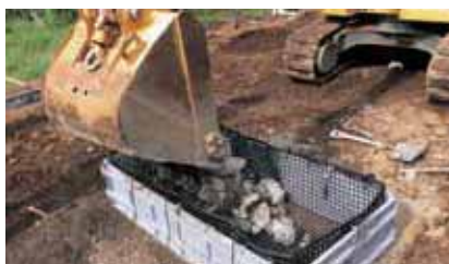
2 中詰材を、拘束ロープ付近まで投入
