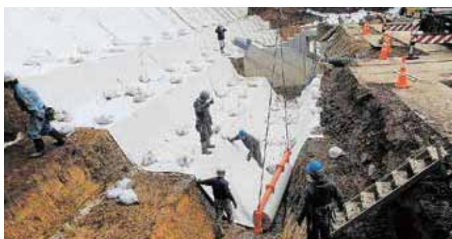
護岸工 ため池堤体改修工事にて遮水性ゾーンに敷設した事例
