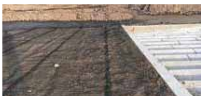
1 メッセルを敷設
