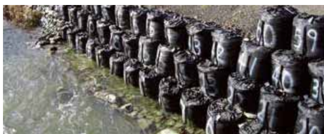
押さえ盛土工 河川の押さえ盛土工として用いた事例
