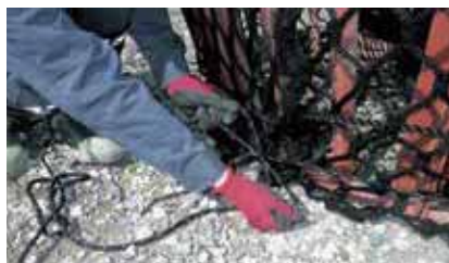
2 網地を型枠に拘束
