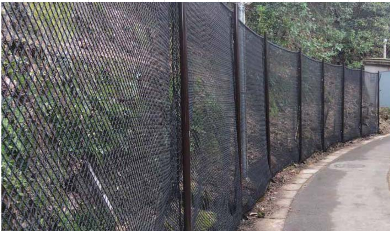
道路横法面の落石対策として設置
