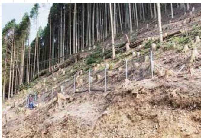
道路横法面の落石対策として設置
