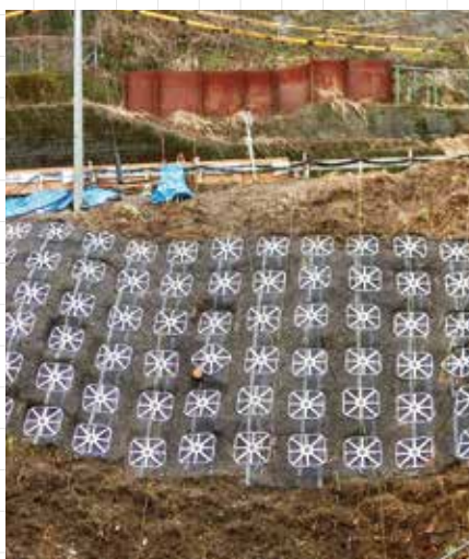
補強土工法の背面
