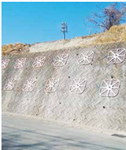
ブロック積擁壁補強
