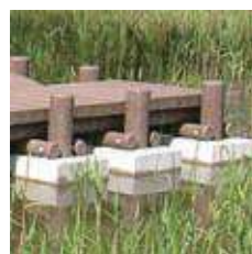
■ コンクリート基礎
