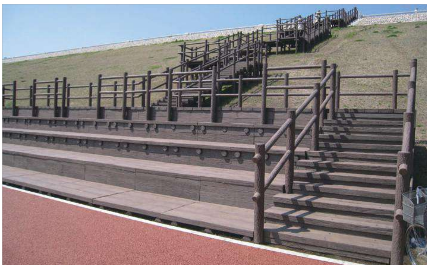
村山下貯水池 東京都／階段デッキ
