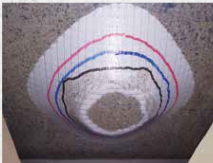
押抜き試験状況 (V2仕様)
