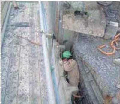
写真-4 壁面材の取りはずし
