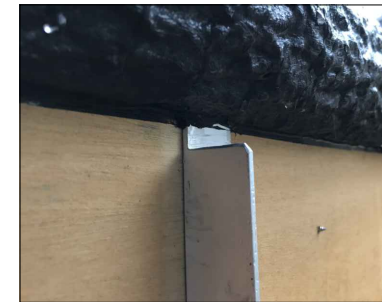
【参考2】アルミアングル取付 横木溝切部に差し込む
