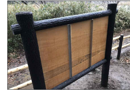
【参考3】アルミアングル取付 アングルが2本背合わせになるよう取付ける
