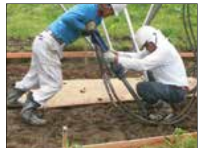
3 鋼管杭の打ち込み
