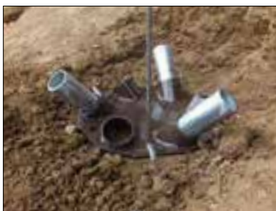
4 鋼管杭の打ち込み完了
