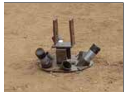
6 C-LESS基礎 設置完了
