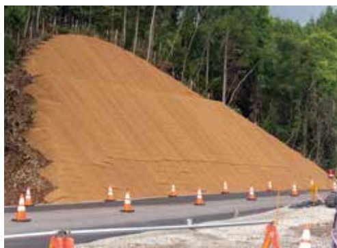
石川県穴水町
