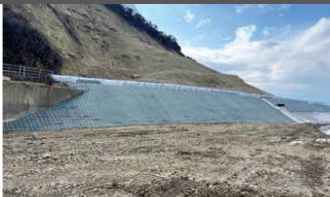
道路啓開工事 石川県珠洲市 GS-RNSK
