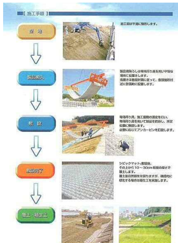
シビックマット施工手順
