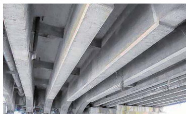
RC主桁の補強
