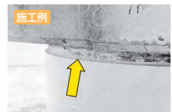
鋼板巻立て工法用シール材
