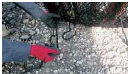
2 網地を型枠に拘束
