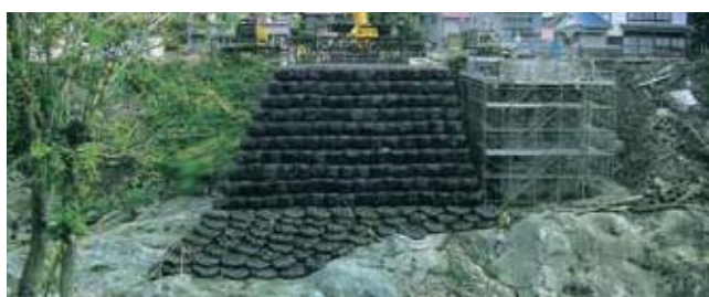
仮設工 仮設橋台上BUウォール工法と併用して用いた事例
