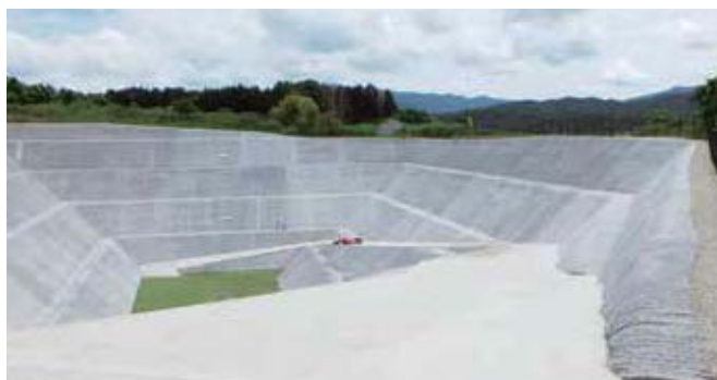
のり面保護工 調整池・ため池ののり面保護として用いた事例
