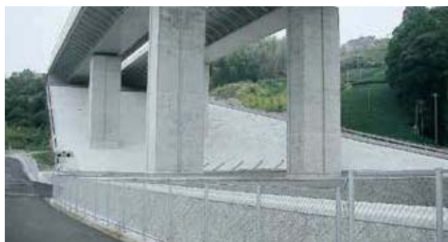
のり面保護 のり面の防草用途として用いた事例
