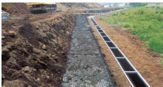
土留工 腐食の恐れがある環境下にて、鉄製ではなく繊維製が採用された事例
