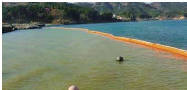
漁港での災害復旧の際に汚水の流出を防いだ事例
