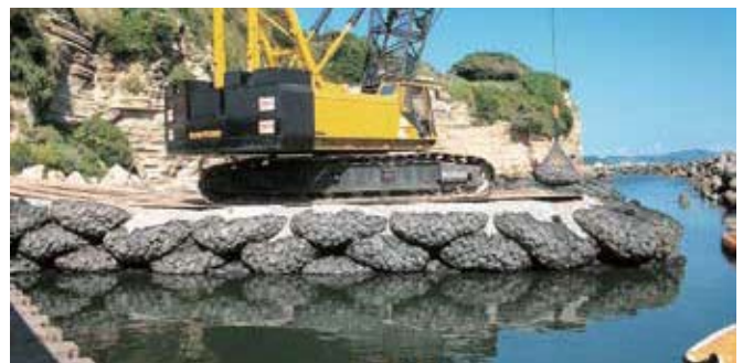
仮設工 施工ヤードの土台として用いた事例
