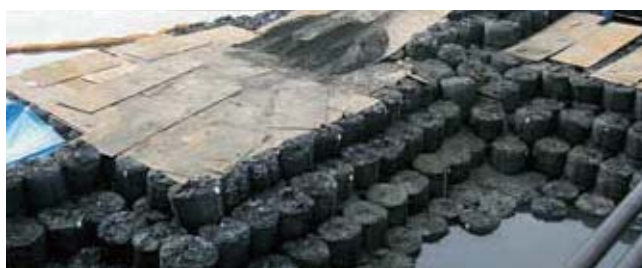
土留工 施工ヤードの土留工として用いた事例
