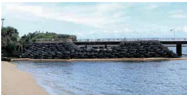
仮設工 施工ヤードの土台として用いた事例
