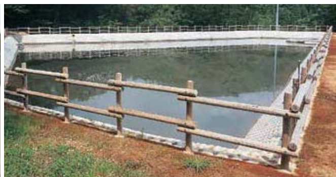
のり面保護工 調整池・ため池ののり面保護として用いた事例
