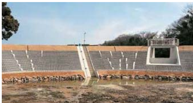
ため池護岸 ため池の護岸に用いた事例(防災タイプ)
