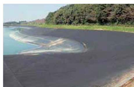
遮水工 ため池改修工事にて保護マット上部にシートを敷設した事例
