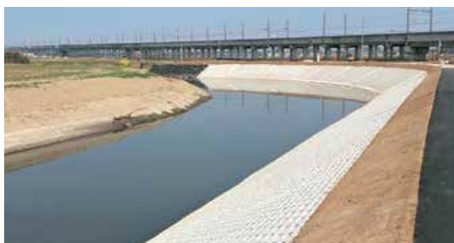
河川護岸 河川護岸に用いた事例(標準タイプ)
