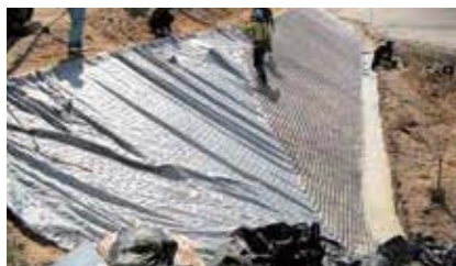
2 モルタル注入
