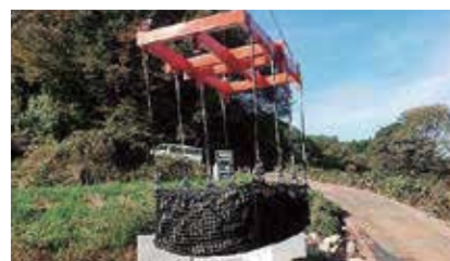
6 吊上げ具を用いて、所定の位置に移動
