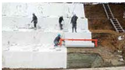
2 シートの敷設
