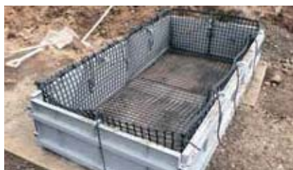
1 型枠に網地を設置
