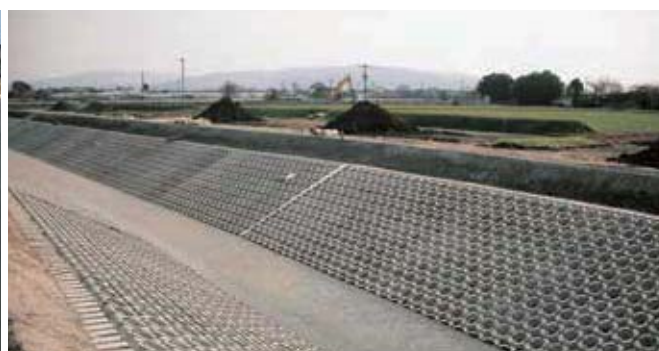
河川護岸 河川護岸に用いた事例(標準タイプ)
