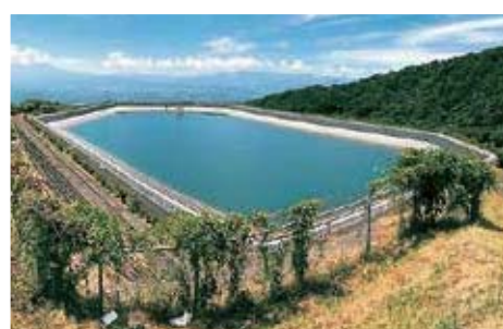
遮水工 ため池工事にて長尺広幅シートで敷設した事例
