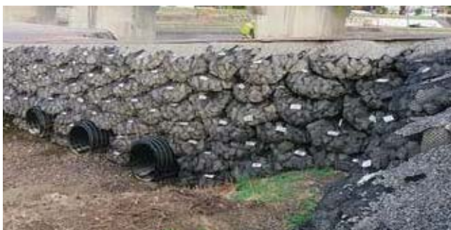
仮設工 工事用の仮設道路として用いた事例
