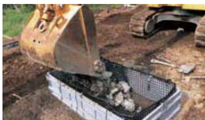
2 中詰材を、拘束ロープ付近まで投入
