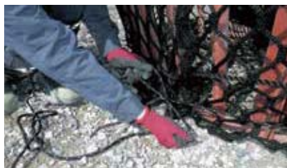
2 網地を型枠に拘束
