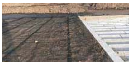
1 メッセルを敷設
