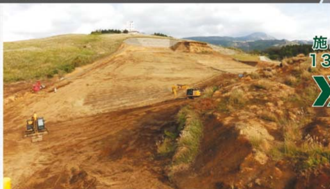
熊本県：黒ぼく土の緑化（資材：FSS-III）
