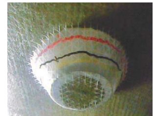
押抜き試験状況
