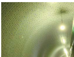
トンネル壁面
