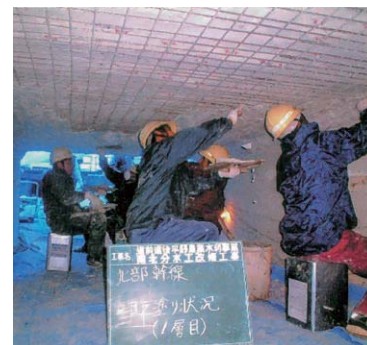
ボックスカルバートの頂版補強
