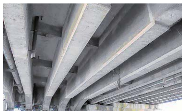
RC主桁の補強
