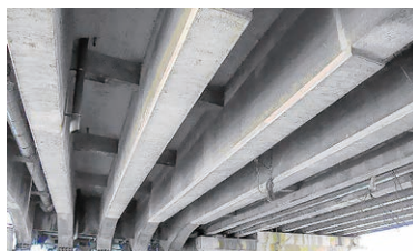
RC主桁の補強
