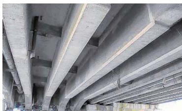
RC主桁の補強
