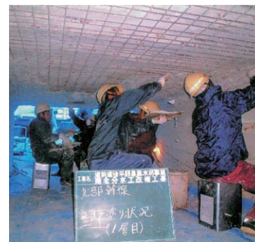
ボックスカルバートの頂版補強
