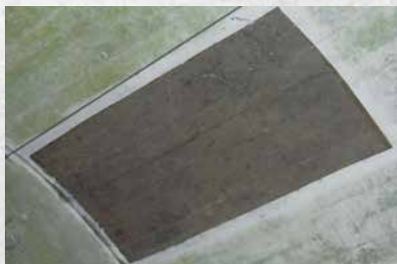
貼付け後は透明となり、躯体状況が確認できます
