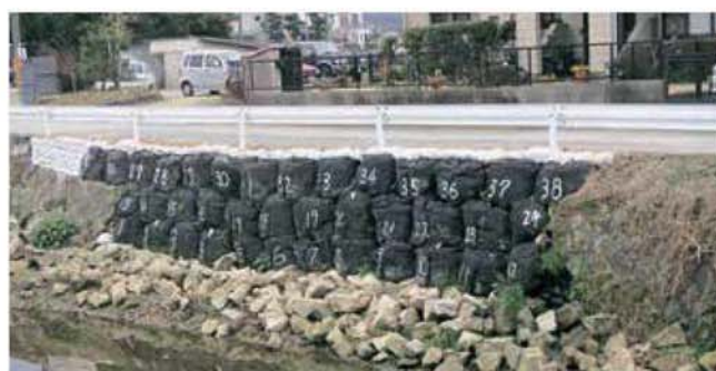
押さえ盛土工 法面の地すべり対策として押さえ盛土をした事例
