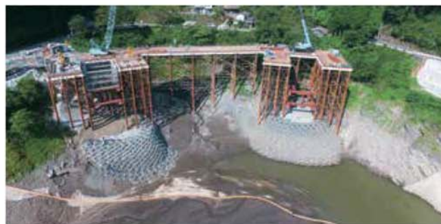
仮設工 工事用橋梁の根固めとして用いた事例
