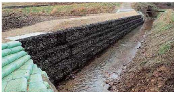
護岸工 災害復旧時の護岸工として用いた事例
