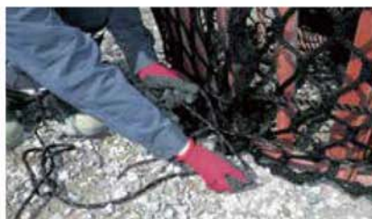
2 網地を型枠に拘束
