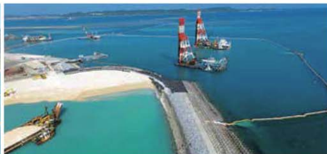
造成工事の際に汚水の流出を防いだ事例
