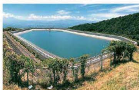
遮水工 ため池工事ににて長尺広幅シートで敷設した事例
