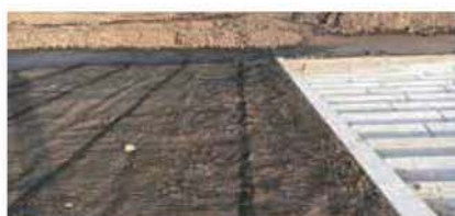
1 メッセルを敷設
