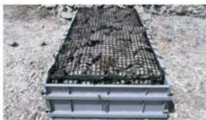
5 上蓋部を側面部と蓋閉じロープで結束
