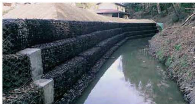
護岸工 災害復旧時の護岸工として用いた事例
