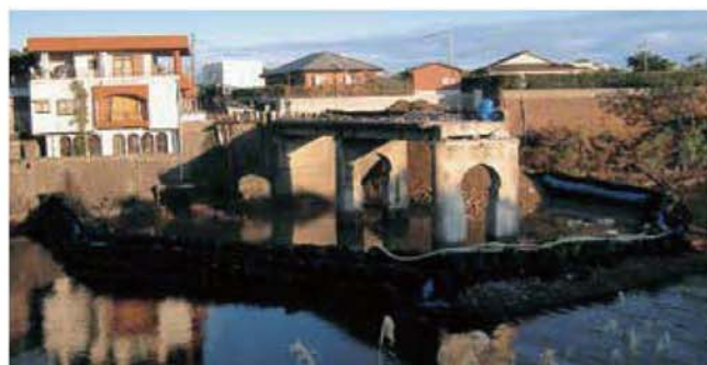
仮締切工 橋脚周りに仮締切として用いた事例
