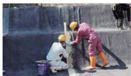
4 重ね合わせ部処理(法面部)
