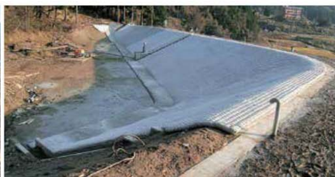
遮水工 デクトシートを敷設後、モデム(布製型枠)を施工した事例
