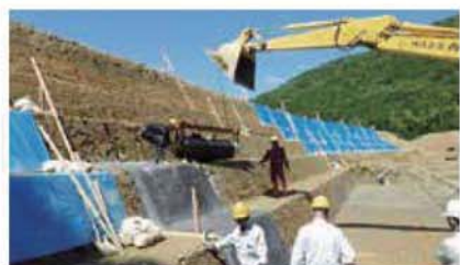
1 シートの敷設
