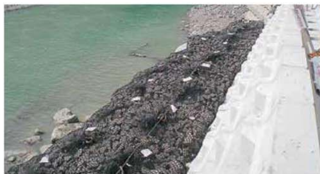
根固工 工事用仮設道路の根固めに用いた事例
