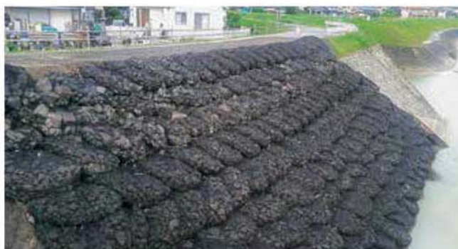
災害復旧 護岸ブロックが破壊された箇所の応急復旧として用いた事例
