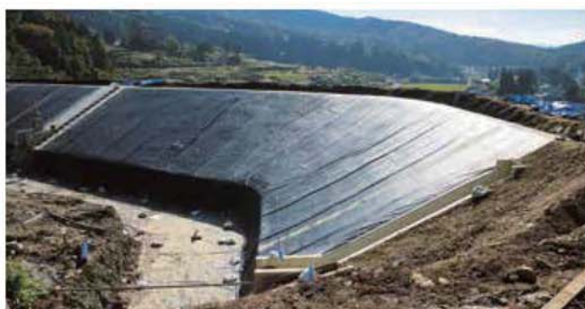
遮水工 デクトシートを敷設後、モデム(布製型枠)を施工した事例
