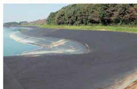
遮水工 ため池改修工事ににて保護マット上部にシートを敷設した事例
