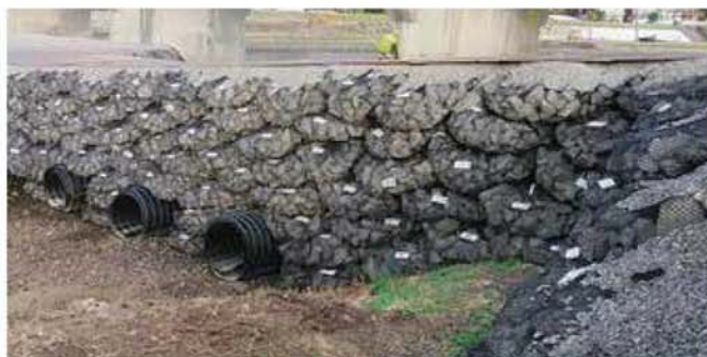
仮設工 工事用の仮設道路として用いた事例
