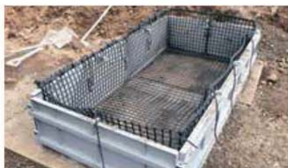
1 型枠に網地を設置
