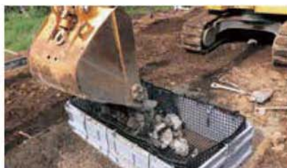
2 中詰材を、拘束ロープ付近まで投入
