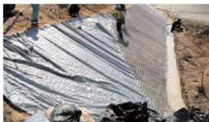
2 モルタル注入
