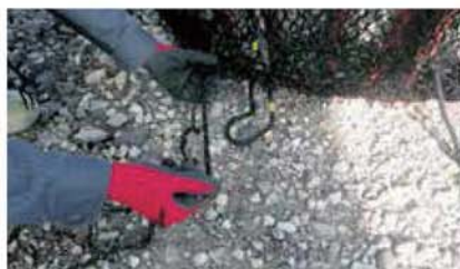
2 網地を型枠に拘束
