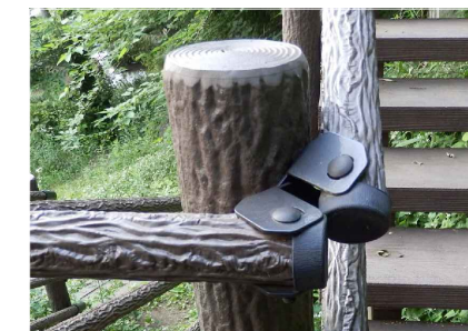
【参考4】自在金具とビームの取付 (コーナーから傾斜)
