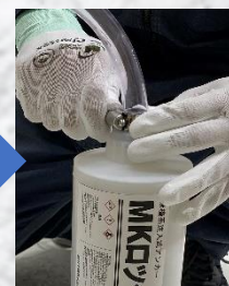
接続ノズルをカートリッジに取付け後、ホースを取付ける
