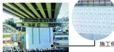
耐震補強・コンクリート巻き立て工
