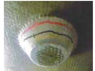
押抜き試験状況
