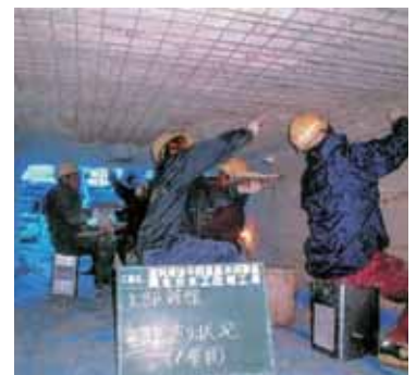
ボックスカルバートの頂版補強
