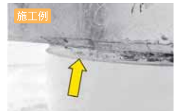
鋼板巻立て工法用シール材
