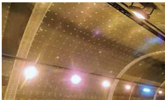
某トンネルはく落対策。不良部が多く広範囲で設置
