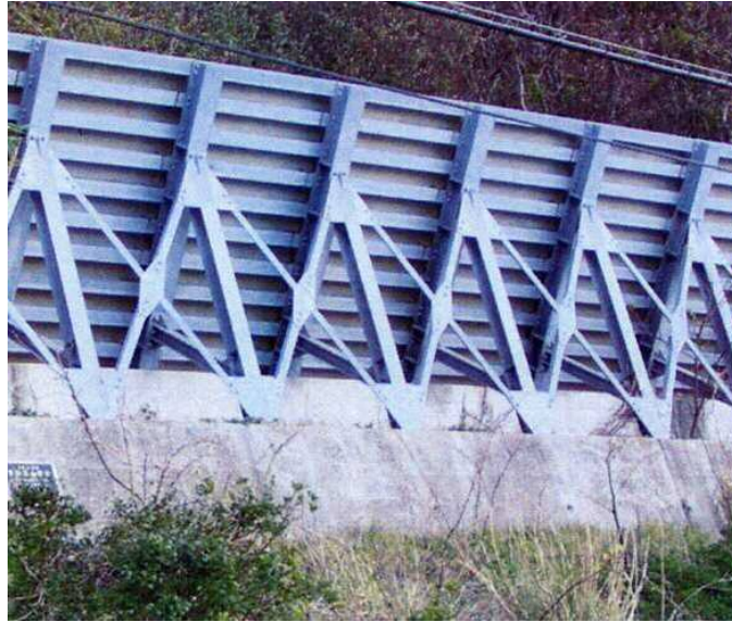
落石防護柵の防錆
