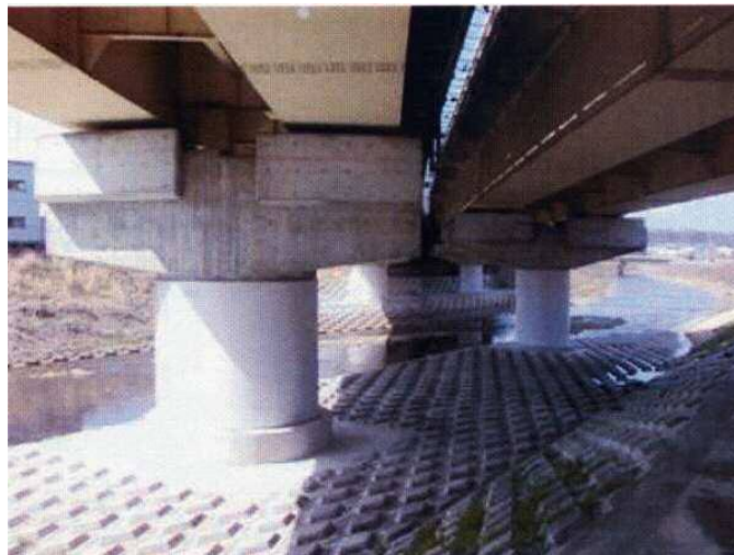
橋脚補強工事(巻き立て鋼板の防錆 t=2.0mm)
