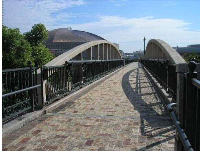
ふれあい橋跨道部防錆工事(臨海地区 経年16年)
