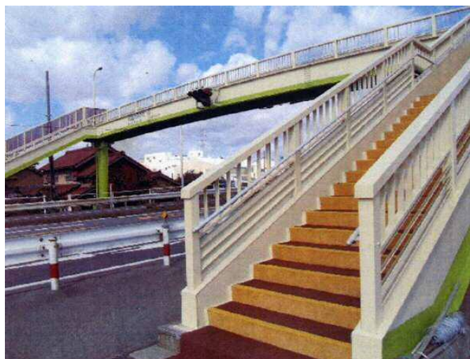
横断歩道橋の防錆
