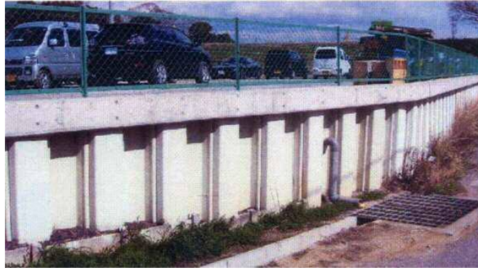
鋼矢板の防錆
