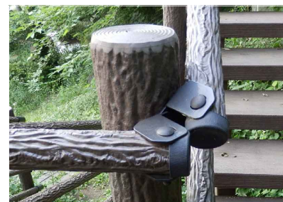
【参考3】自在金具とビームの取付 (コーナーから傾斜)
