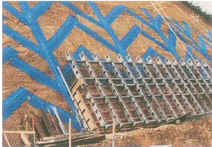
のり面排水および構造物裏込排水
