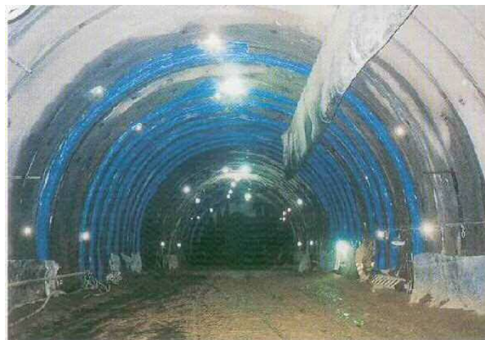
トンネル裏面排水
