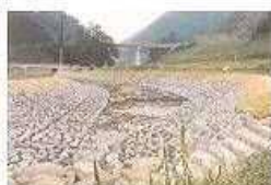
⑥敷設完了
