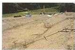
①丁張り設置・法面整形
