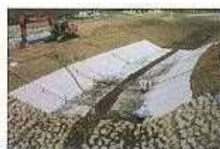
②吸出し防止材敷設
