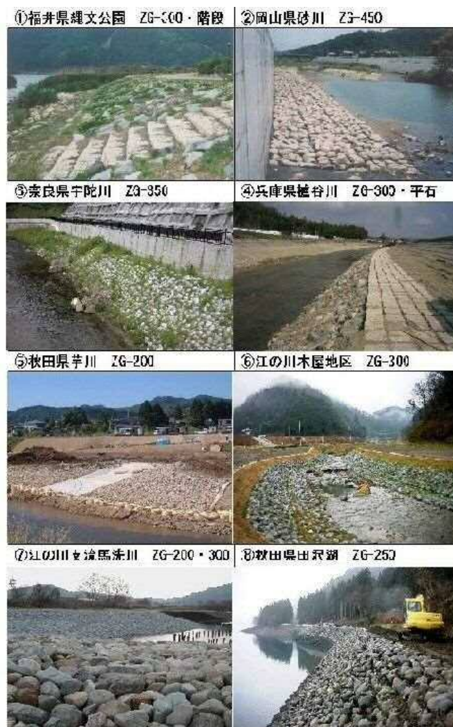
がんどりまっと施工事例写真
