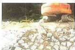
⑤覆土・間詰め工
