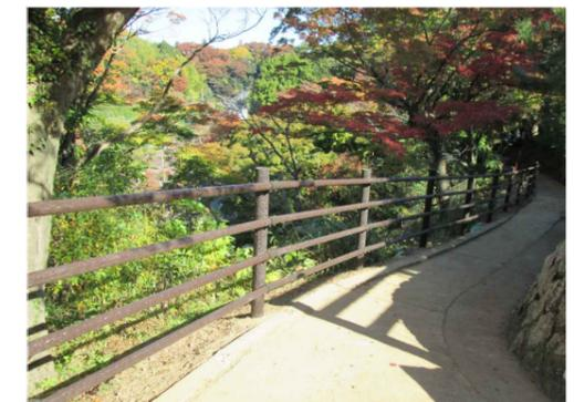
【参考7】完成例（鋼管打ち込み式四段柵）
