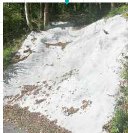
モルタル吹付面経過観察 (5 か月後)
