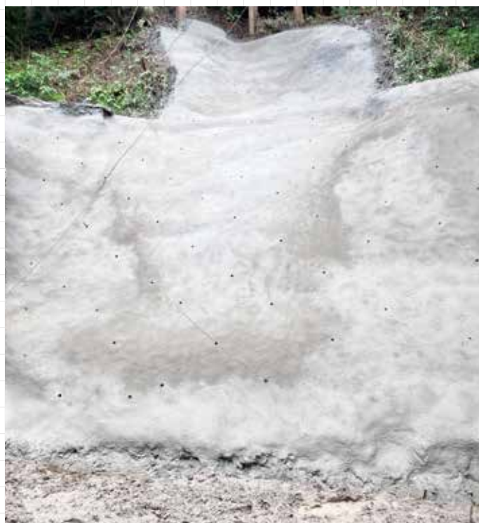
モルタル吹付後の様子
