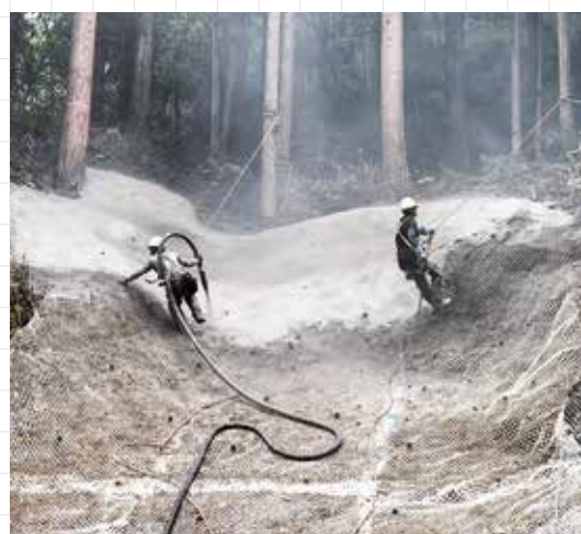
モルタル吹付の様子
