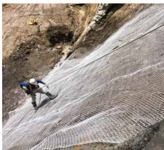
プラス網敷設の様子
