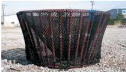
1 袋材設置(袋の底が少し浮く位置に設置)
