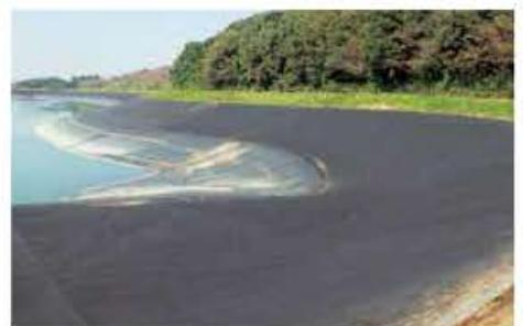
遮水工 ため池改修工事にて保護マット上部にシートを敷設した事例
