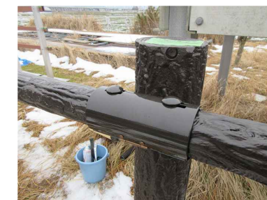
【参考1】フロント金具と横木の取付 (支柱表側より)
