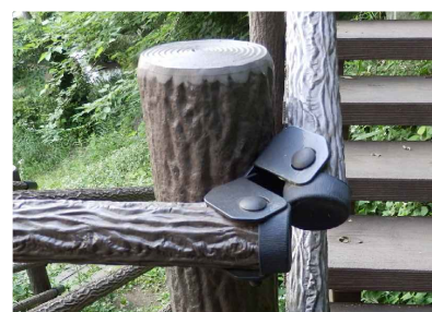
【参考5】自在金具と横木の取付 (コーナーから傾斜)
