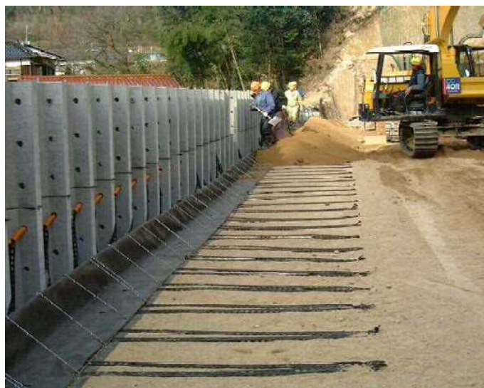
写真-1 施工状況
