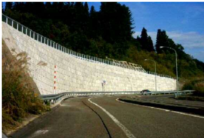
写真-5 関越自動車道堀之内PA(斜壁タイプ)
