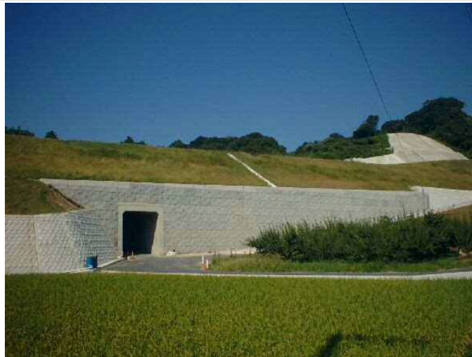
写真-3 阪和自動車道芳養工事(壁面あと施工タイプ)
