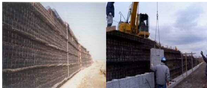
写真-4 有明沿岸自動車道(壁面あと施工タイプ)
