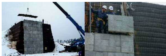
写真-2実物大補強土壁の載荷試験及び壁面補修試験状況
