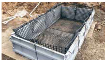
1 型枠に網地を設置
