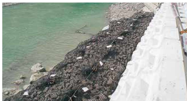
根固め工 工事用仮設道路の根固めに用いた事例
