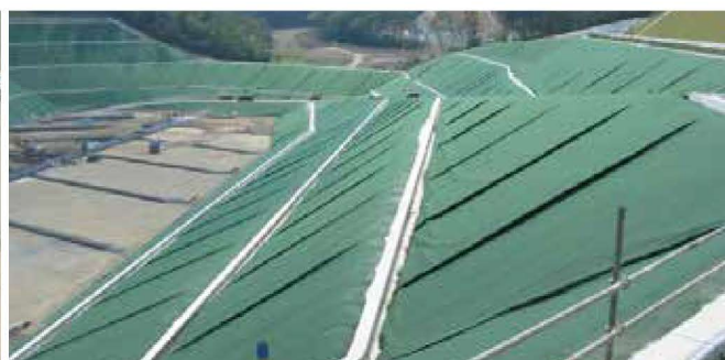
最終処分場にて遮水シートの保護材として用いた事例
