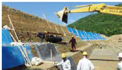
1 シートの敷設
