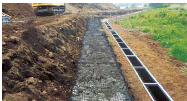
土留め工 腐食の恐れがある環境下にて、鉄製ではなく繊維製が採用された事例
