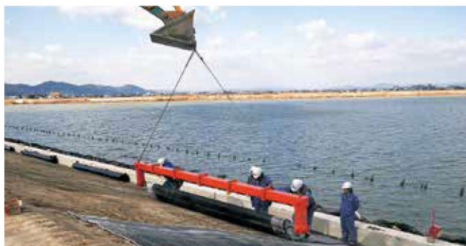
護岸工 張りブロックの下部に敷設した事例
