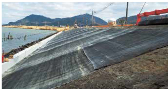
護岸工 張りブロックの下部に敷設した事例
