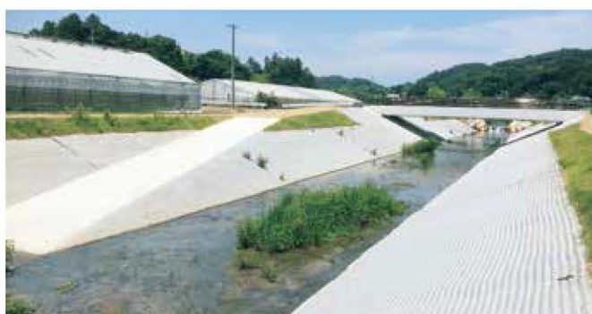
法面保護工 河川の法面保護として用いた事例
