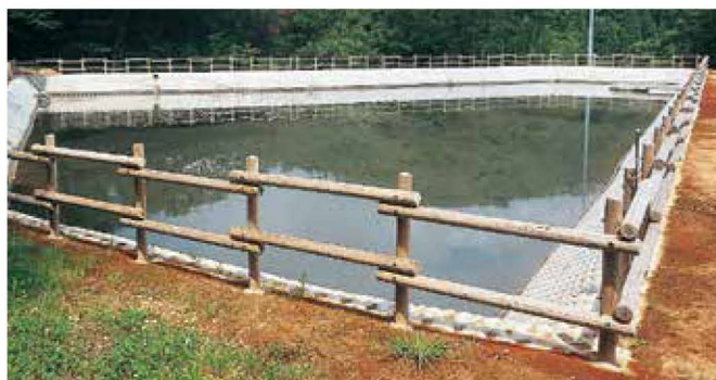
法面保護工 調整池・ため池の法面保護として用いた事例
