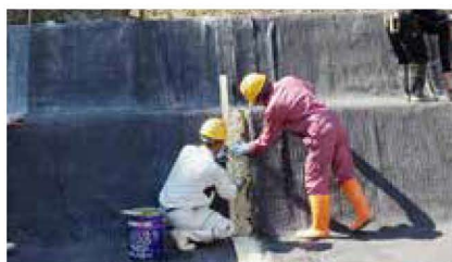
4 重ね合わせ部処理(法面部)
