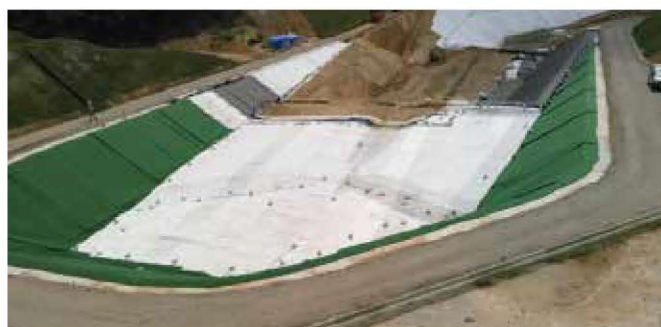
最終処分場にて遮水シートの保護材として用いた事例
