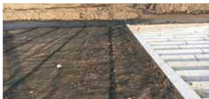
1 メッセルを敷設
