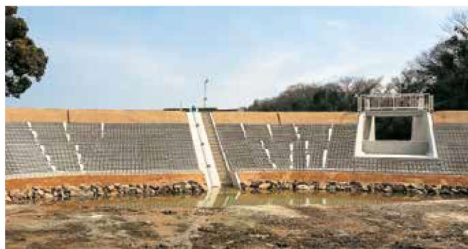
ため池護岸 ため池の護岸に用いた事例(防草防災タイプ)
