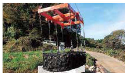
6 吊り上げ具を用いて、所定の位置に移動
