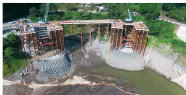
仮設工 工事用橋梁の根固めとして用いた事例
