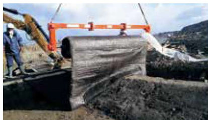
2 シートの敷設(重ね合わせ) ※ナベント専用吊り具を貸出しています。
