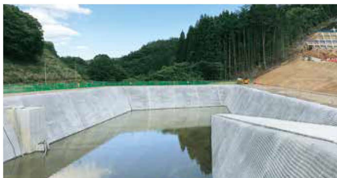
法面保護工 調整池・ため池の法面保護として用いた事例
