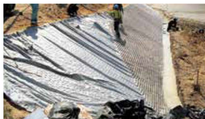
2 モルタル注入
