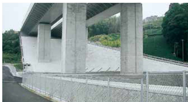
法面保護 法面の防草用途として用いた事例
