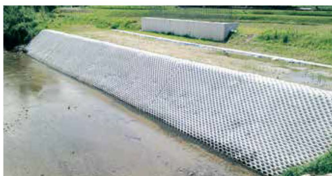
法面保護工 河川の法面保護として用いた事例
