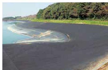
遮水工 ため池改修工事ににて保護マット上部にシートを敷設した事例
