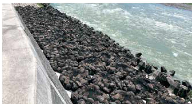
根固め被覆 根固めブロックの被覆材として用いた事例
