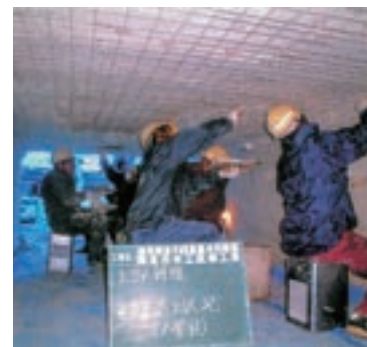
ボックスカルバートの頂版補強
