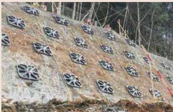
切土法面補強
