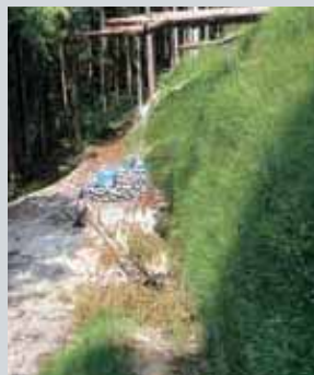
宮城県大崎市鳴子／Ⅰ型／推定落石エネルギー：約2500kJ／事故後の対応：全撤去後再構築を行いました
