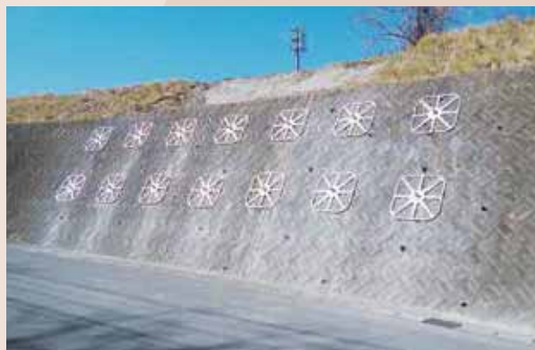
老朽化擁壁補強
