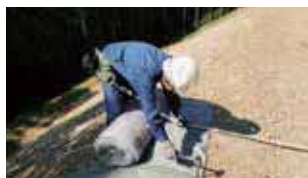
法肩部分の固定
