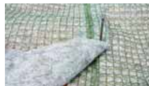
隣接する製品を所定の位置でラップ アンカーおよび止め釘で固定
