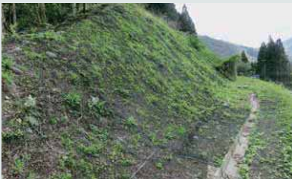
石川県(覆式落石防護網工)
