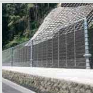
落石防護柵工 ループフェンス
