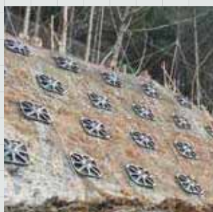
地山補強土工 MK受圧板
