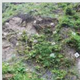
地山補強土工 マクロネットHR
