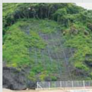
覆式落石防護柵工 GMネット
