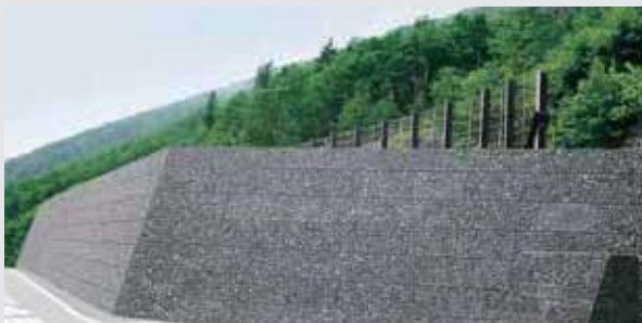
静岡県富士山富士宮口 前面側の表面には日本ナチュロック(株)製・ピオフィルム®ハードタイプが設置されています。 (※ピオフィルムは日本ナチュロック(株)の登録商標です)
