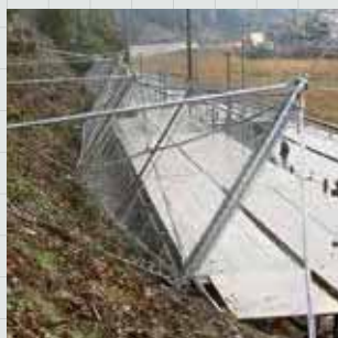
落石防護柵工 ARCフェンス
