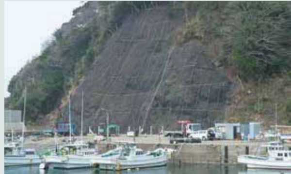
長崎県(覆式落石防護網工)
