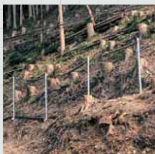
落石防護柵工 GMネット防護柵
