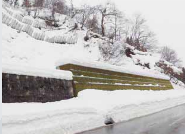
山形県最上郡真室川町(壁高4.5m)
