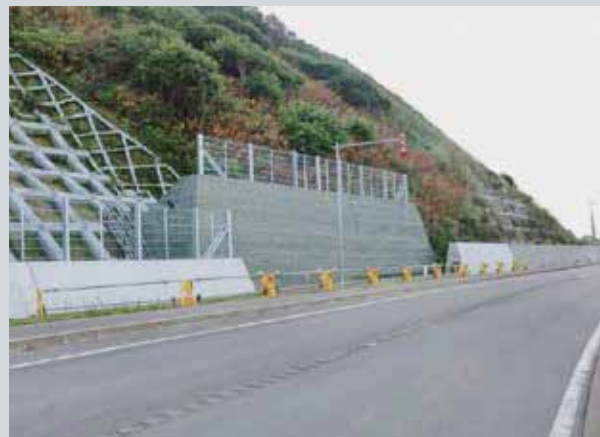
北海道苫前郡苫前町 (壁高5.0m)
