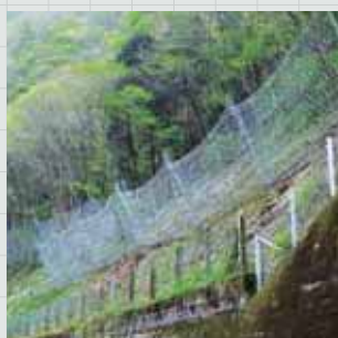
落石防護柵工 MJネット
