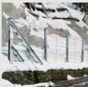
落石防護柵工 ストロンガー工法
