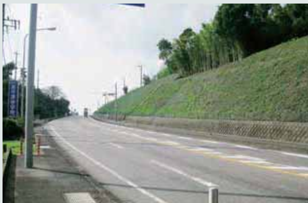
宮崎県(切土斜面 法面保護)
