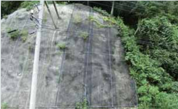
福井県(覆式落石防護網工)
