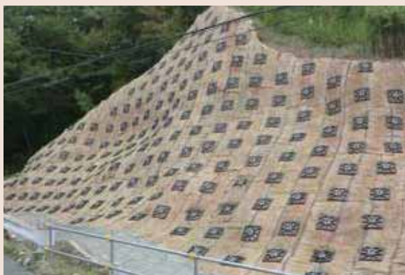
切土法面補強
