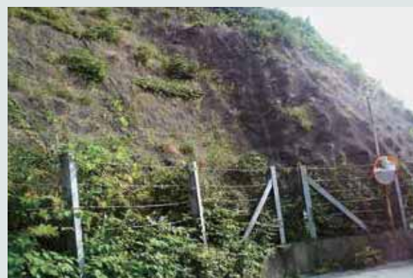
滋賀県米原市(自然斜面 法面保護)
