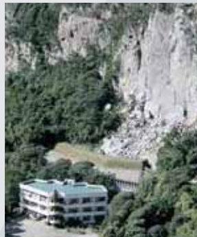
東京都新島／Ⅲ型／推定落石エネルギー：約7000kJ／事故後の対応：防護マット破損部を取り換えました
