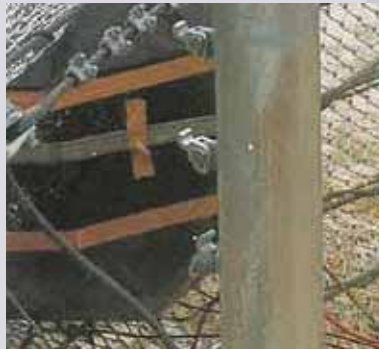
変位制限装置が解除されることで広範囲の 阻止面で落石エネルギーを吸収します
